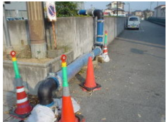
仮設配管「リユーズシステム」施工例
