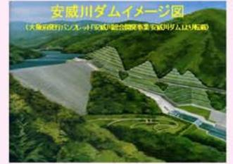
そのため、総貯水量1700万トンの治水ダムを建設し、安威川沿川地域の水害を防ぐことを予定している。
