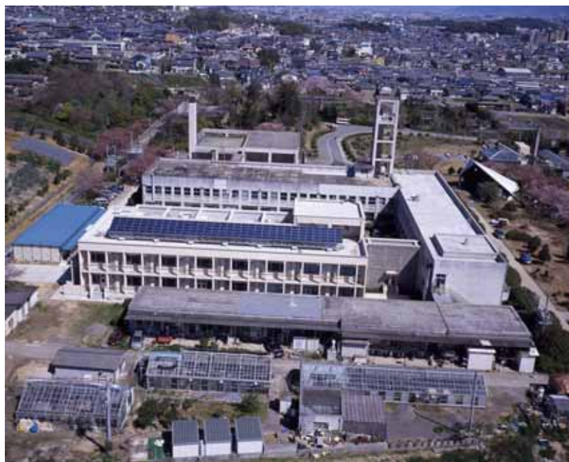
屋上に太陽電池パネルを設置した「食のゼロ・エミッション先端研究施設」
