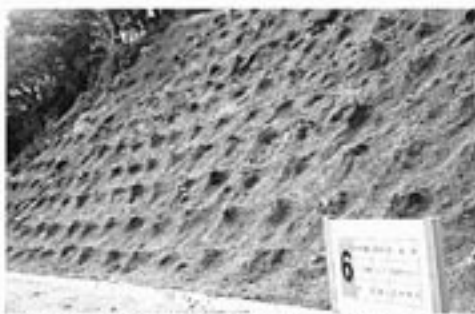
第1図 縦設置型竹筒による法面緑化事例 (神戸) 和泉砂岩層用削法面 (勾配40°)
