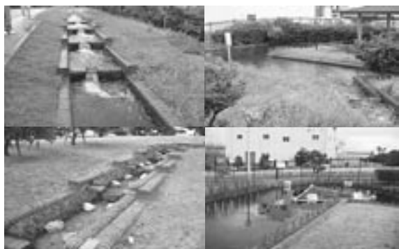
第1図 実験を行った下水処理水放流水路と貯留池
