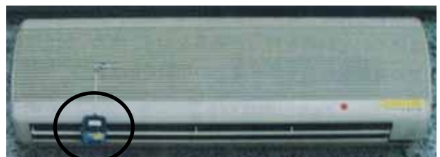
図-2. 測器設置状況
