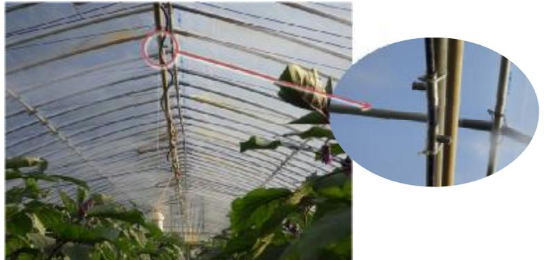
図1 細霧システムの設置状況
