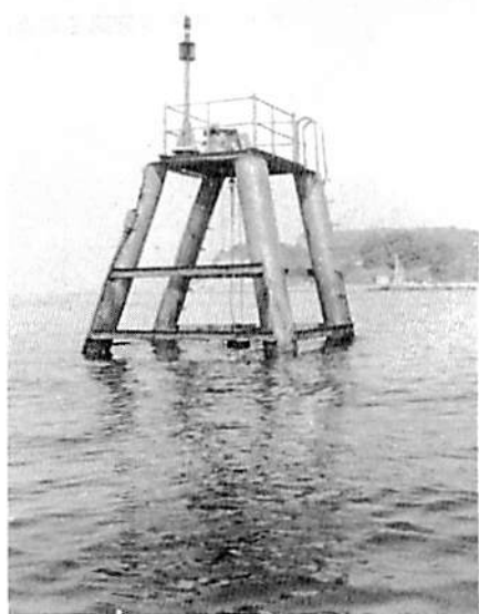
海況自動観測塔
