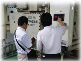
写真1 省エネ診断の様子
