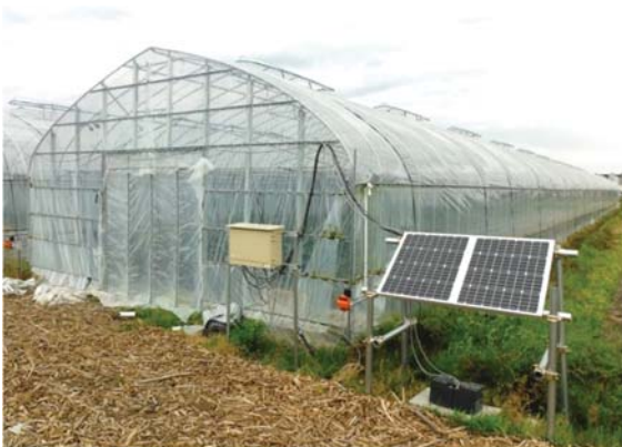
ソーラーパネルを利用したナス自動側面換気装置
