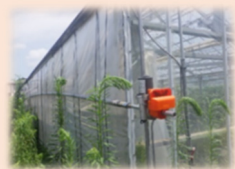
側窓自動開閉の様子
