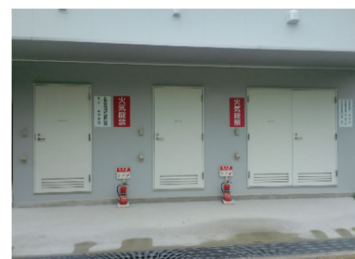
危険物屋内貯蔵所
