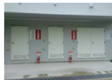
危険物屋内貯蔵所
