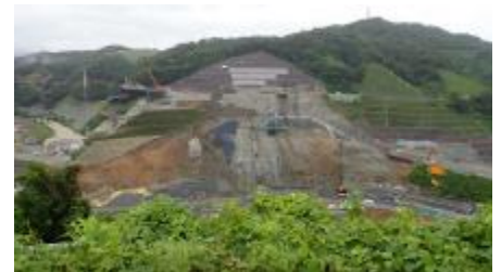
ダム建設現場
