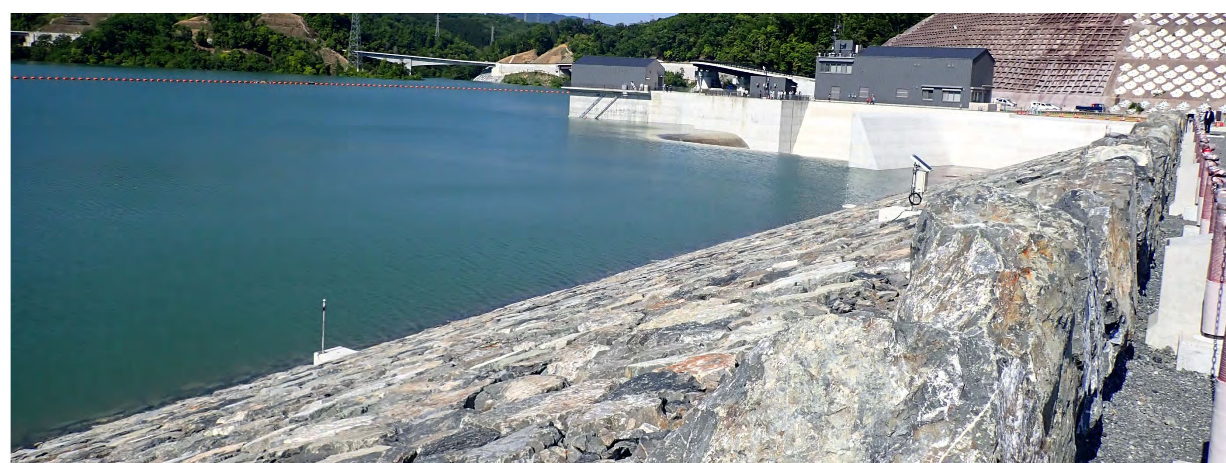
湛水後の安威川ダム（堤体上から）
