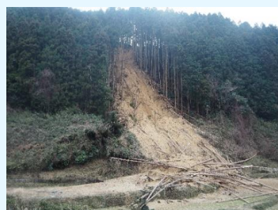
大雨により発生した土砂崩れ
