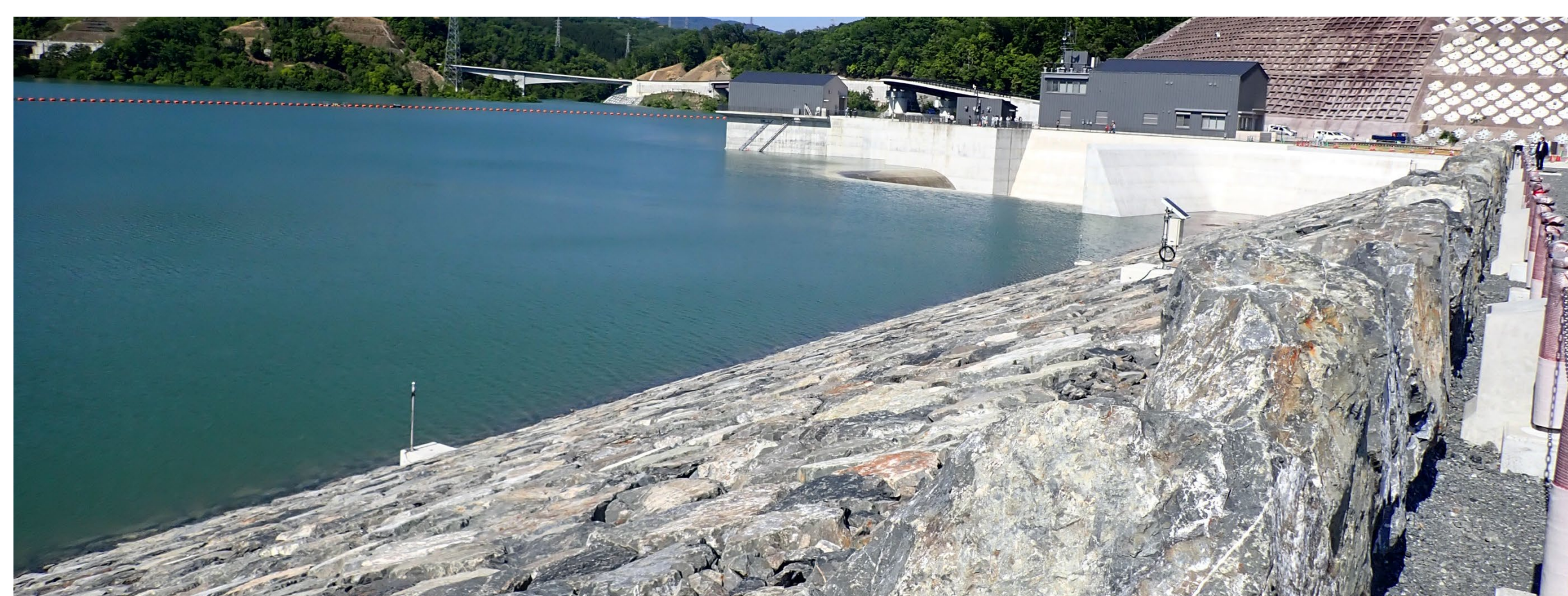
湛水後の安威川ダム（堤体上から）
