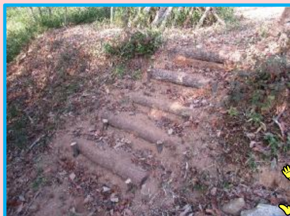
伐採木で階段設置（北摂）
