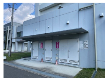
危険物屋内貯蔵所
