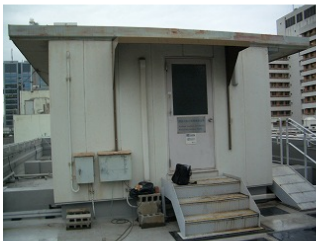
図 2.3 実証対象(屋上)
