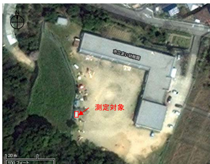
図 2.6 実証対象の折板屋根
