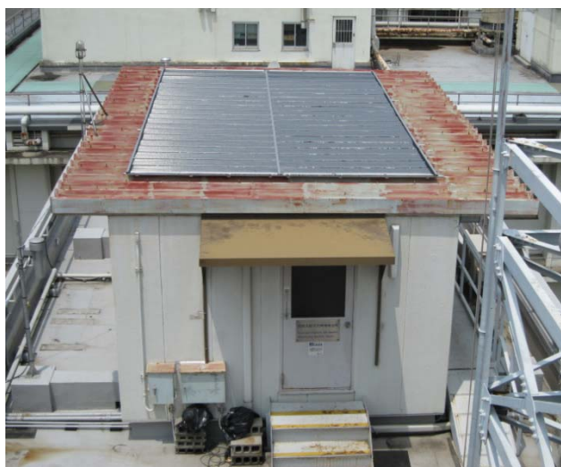
図 2.4 実証対象の折板屋根
