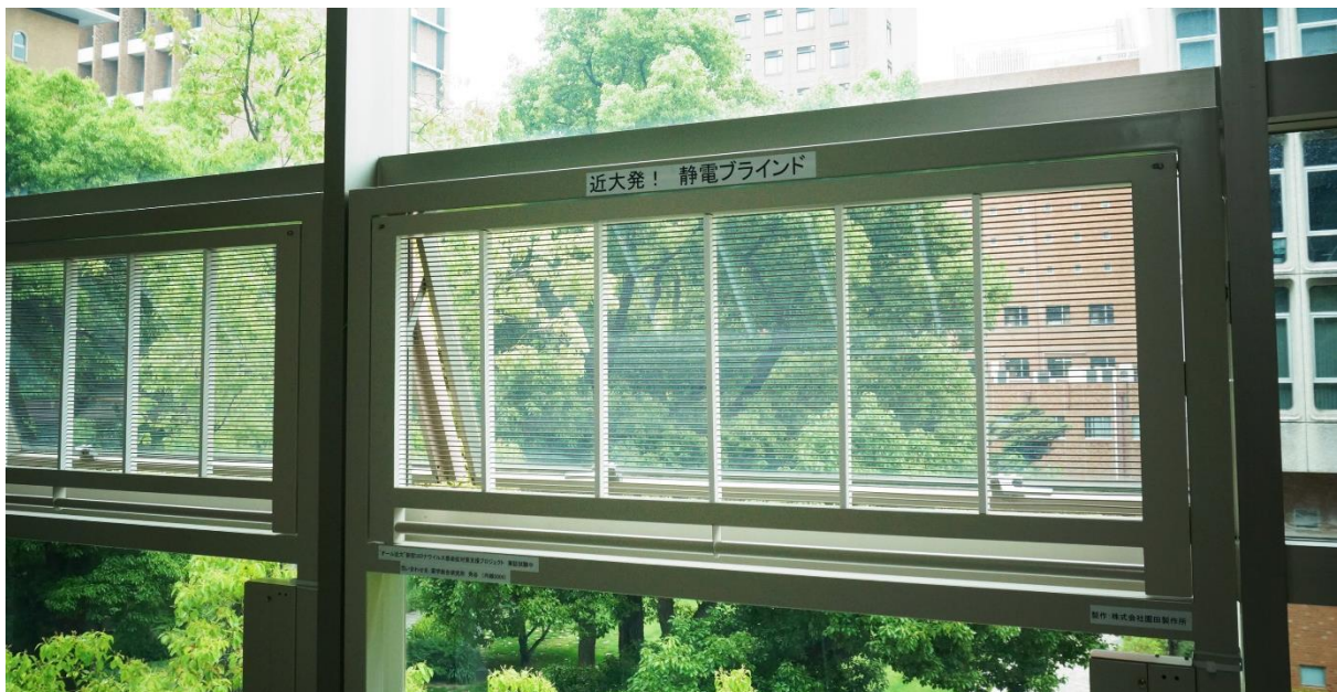
本学教室の窓枠に設置した「静電ブラインド」
